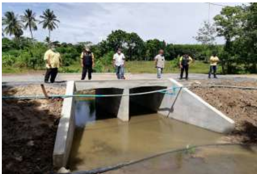
ก่อสร้างท่อลอดเหลี่ยมคอนกรีตเสริมเหล็ก ชนิด 2 ช่องทาง ถนนบ้านหินลับ - บ้านเขาน้อย
